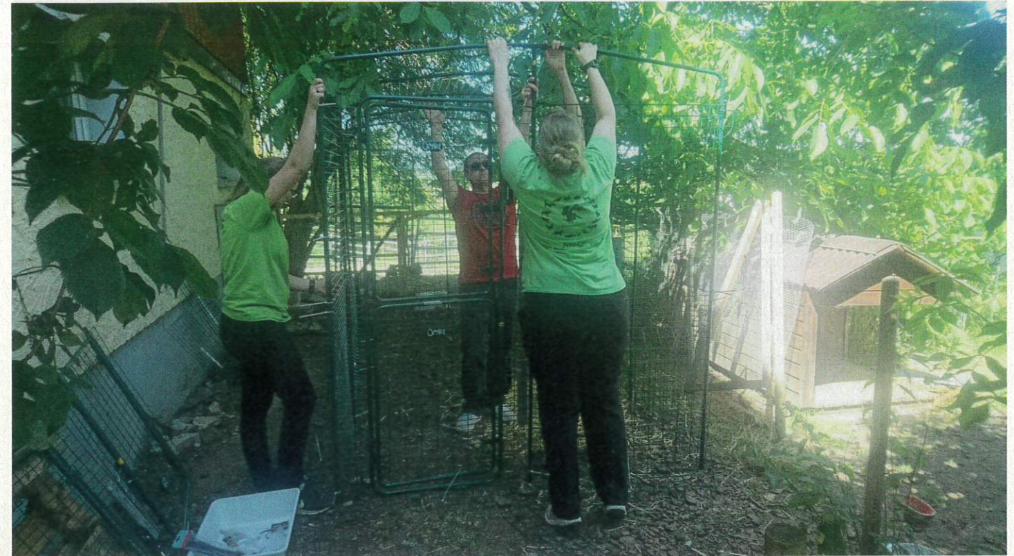
Das Team von NetAP beim Aufbau des Auswilderungszwingers.
