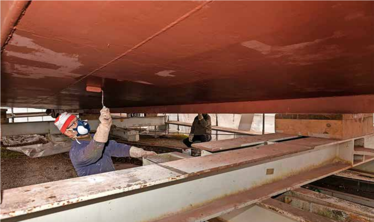
Der Unterboden von Motorschiffen muss in regelmässigen Abständen kontrolliert werden. Hier wird die MS Hallwil frisch ge-strichen, damit der Rumpf vor Korrosion geschützt ist. Fotos Werner Rolli
