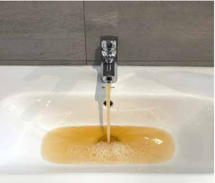
Braun verfärbtes Leitungswasser – ein deutliches Anzeichen für Rost in alten Rohrsystemen.
